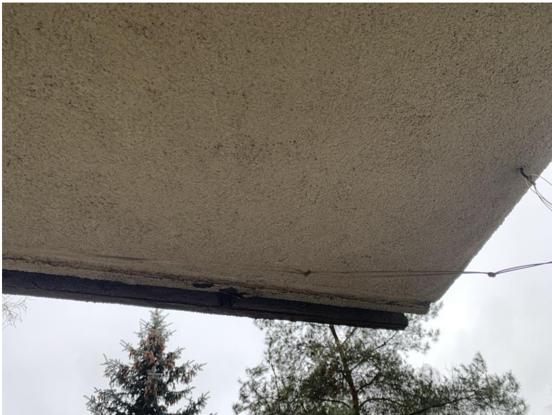
Fot. 5 – widoczne ubytki płyty balkonu od spodu
