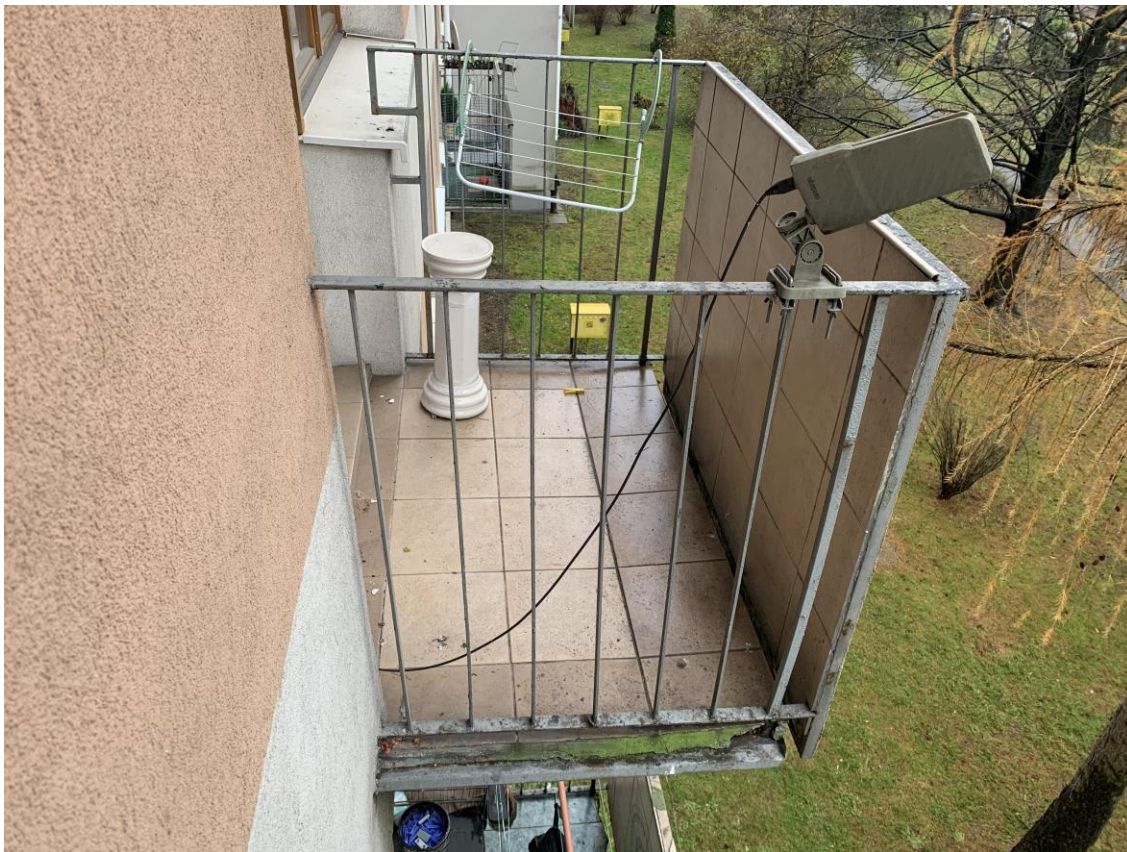
Fot. 2 – zniszczone ofasowanie balkonu, zapadnięte płytki
