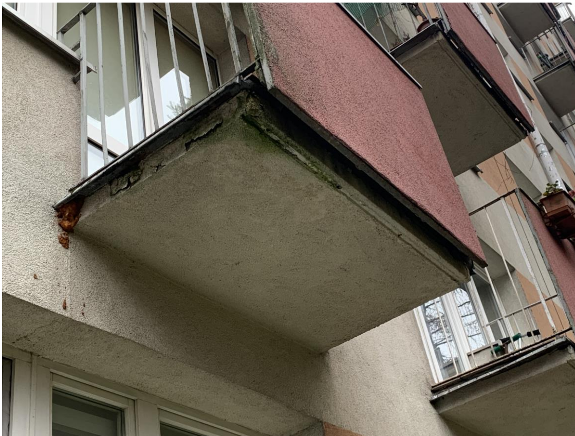
Fot. 6 – widoczne odpryski tynku balkonu
