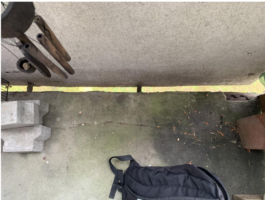
Fot. 3 – pęknięcie powierzchni balkonu
