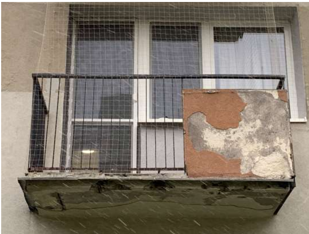
Fot. 6 – płyta balkonowa w złym stanie technicznym – prawie całkowite odpadnięcie tynku z dolnej powierzchni balkonu, liczne ubytki w betonie, uwidocznione zbrojenie
