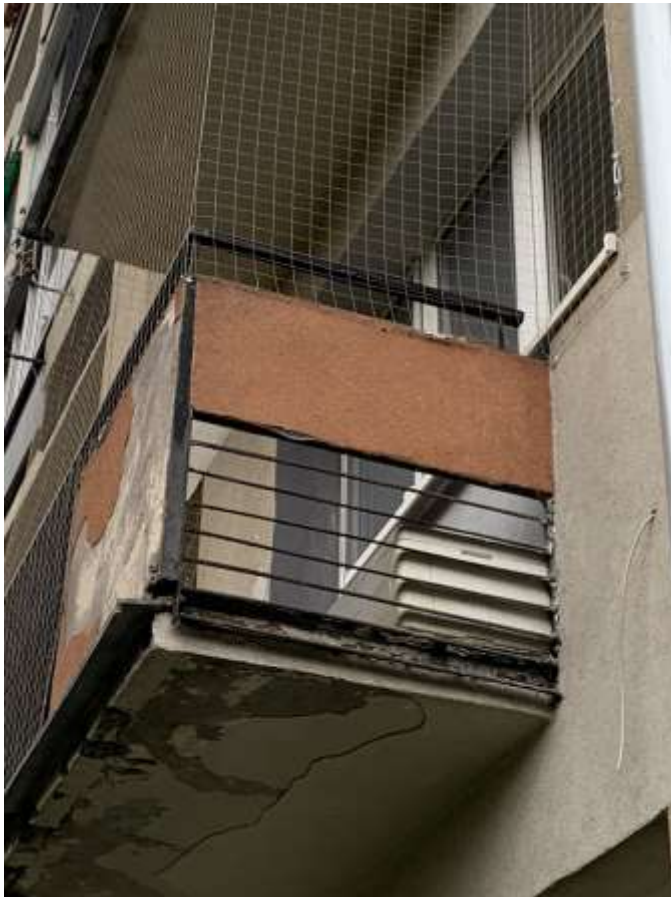
Fot. 7 – płyta balkonowa w złym stanie technicznym – prawie całkowite odpadnięcie tynku z dolnej powierzchni balkonu, liczne ubytki w betonie, uwidocznione zbrojenie
