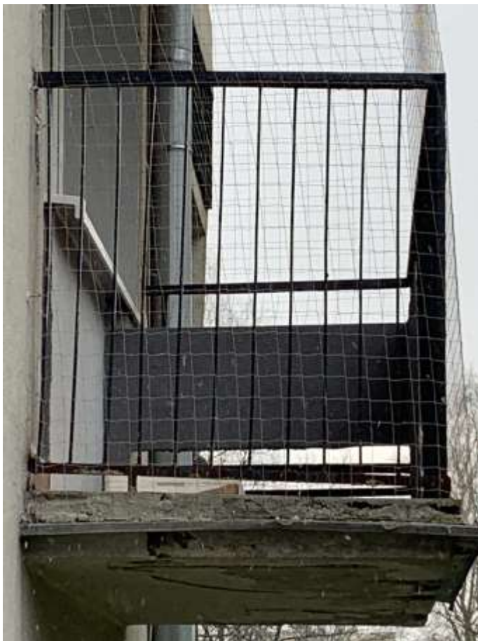
Fot. 8 – płyta balkonowa w złym stanie technicznym – prawie całkowite odpadnięcie tynku z dolnej powierzchni balkonu, liczne ubytki w betonie, uwidocznione zbrojenie
